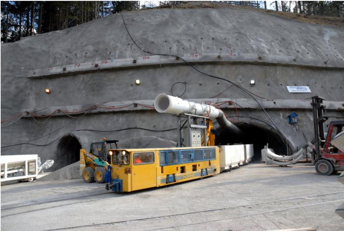
Lo smarino viene trasportato all'imbocco della galleria, dove è stato preparato il piano di caricamento della teleferica.
