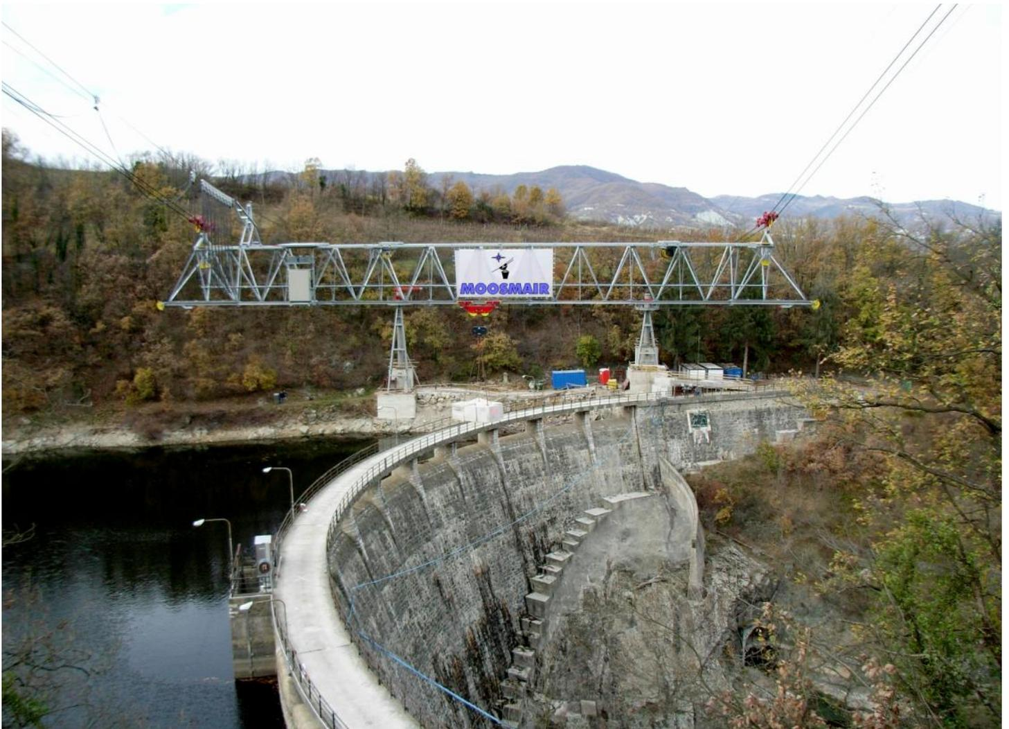
Progettazione, installazione e noleggio della ns. teleferica a trave per i lavori di paramento presso la "Diga di Valla" a Spigno Monferrato (AL)
